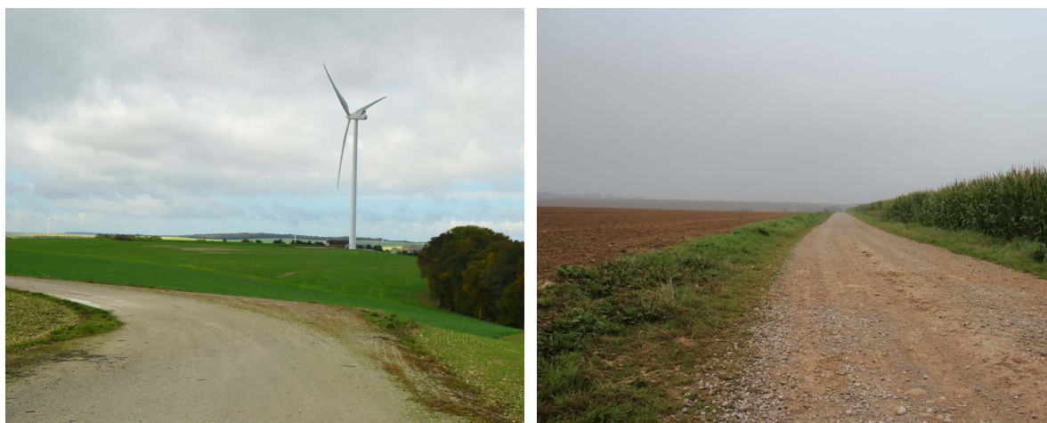
Figure 1: Chemins d'accès maintenus en bon état dans un parc éolien en Haute-Marne
