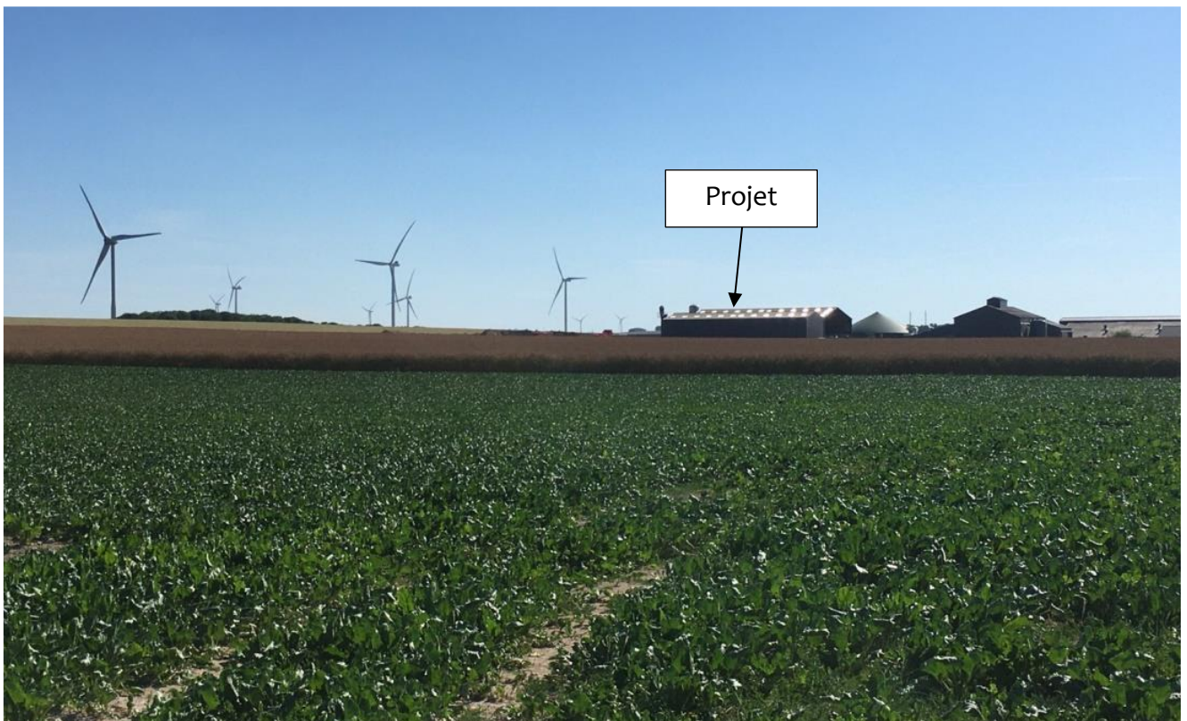
Vue depuis un chemin agricole à l'est de la future unité
