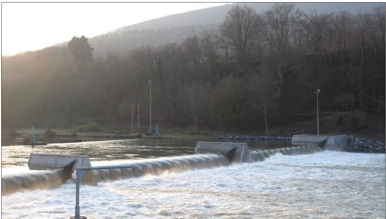
Barrages à bouchures gonflables à l'eau
