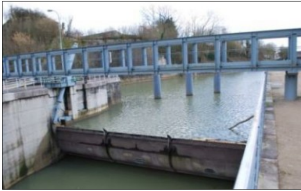
Clapet de Mézières
