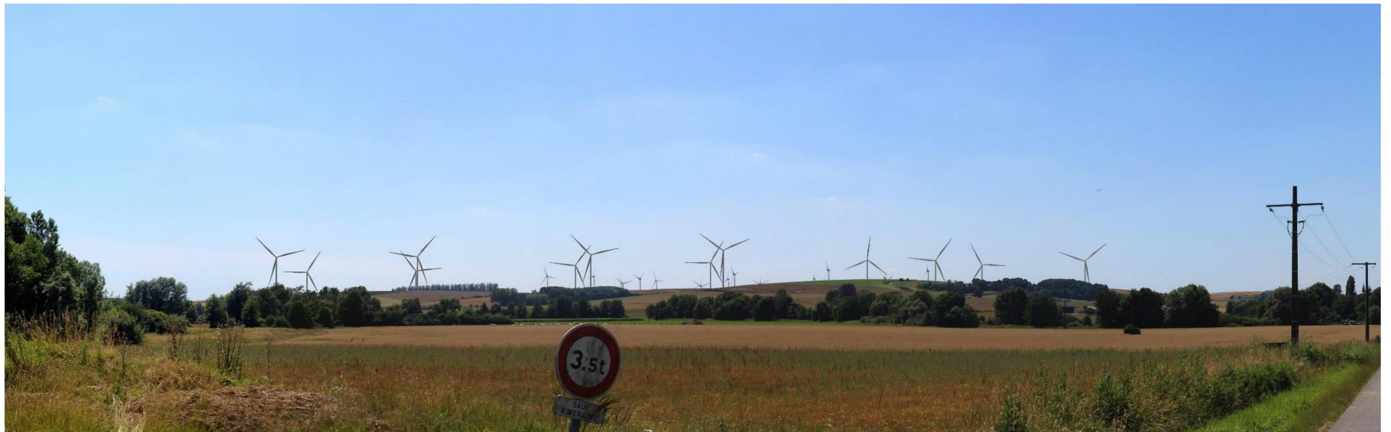
Figure 35 : photomontage réaliste du parc éolien après modification, avec des éoliennes V150, d'une hauteur totale de 180m
