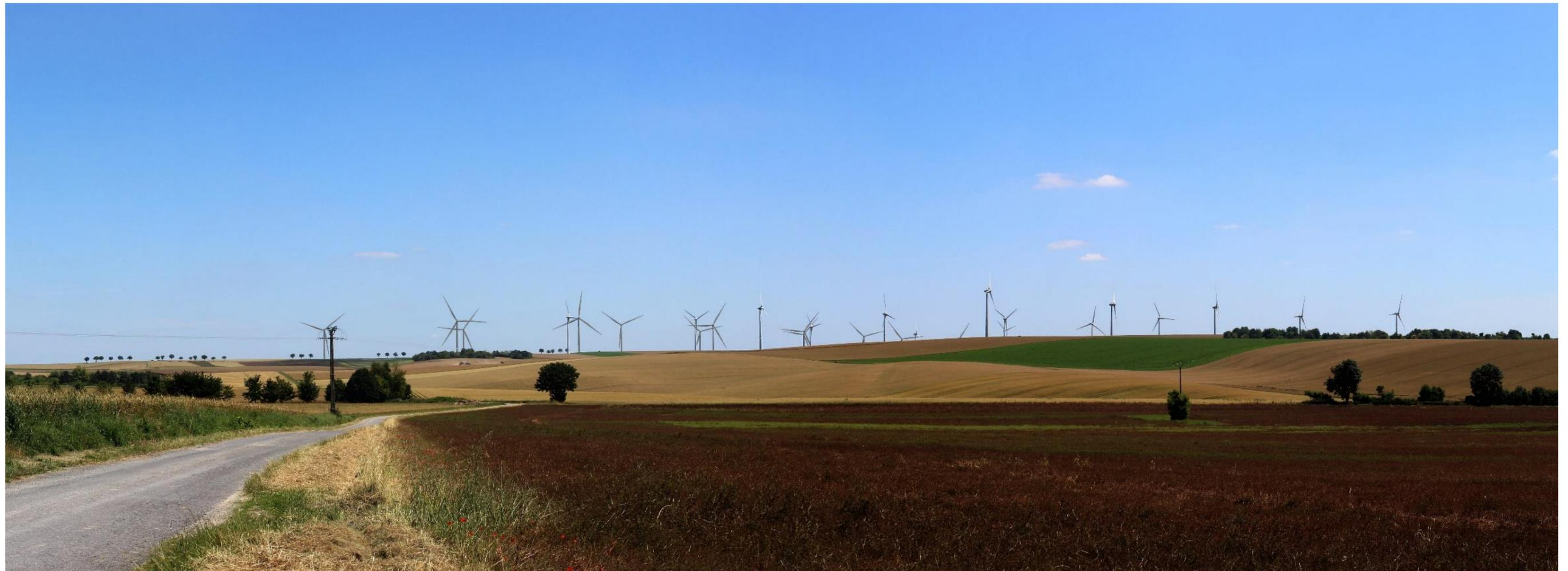
Figure 38 : photomontage réaliste du parc éolien après modification, avec des éoliennes V150, d'une hauteur totale de 180m
