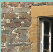
maçonnerie de schistes joint terreux
