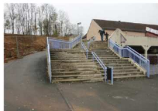
Figure 2 : rampe HP et escalier accès maternelle
