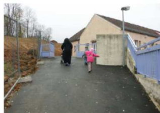
Figure 4 : rampe HP accès maternelle
