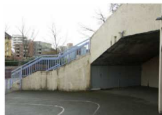
Figure 5 : escalier sur preau maternelle
