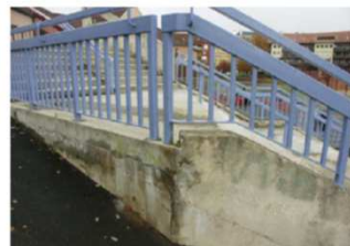
Figure 3 : escalier accès maternelle
