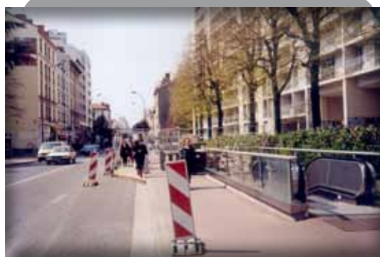
En cas de travaux, il convient de garantir l'accessibilité du cheminement
