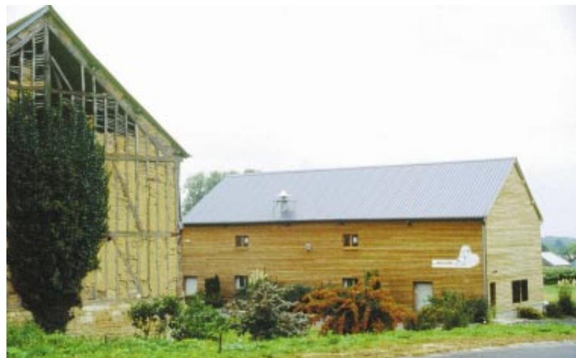
Bâtiment commercial contemporain à Faissault, mariant le bois et la tôle bleu sombre
