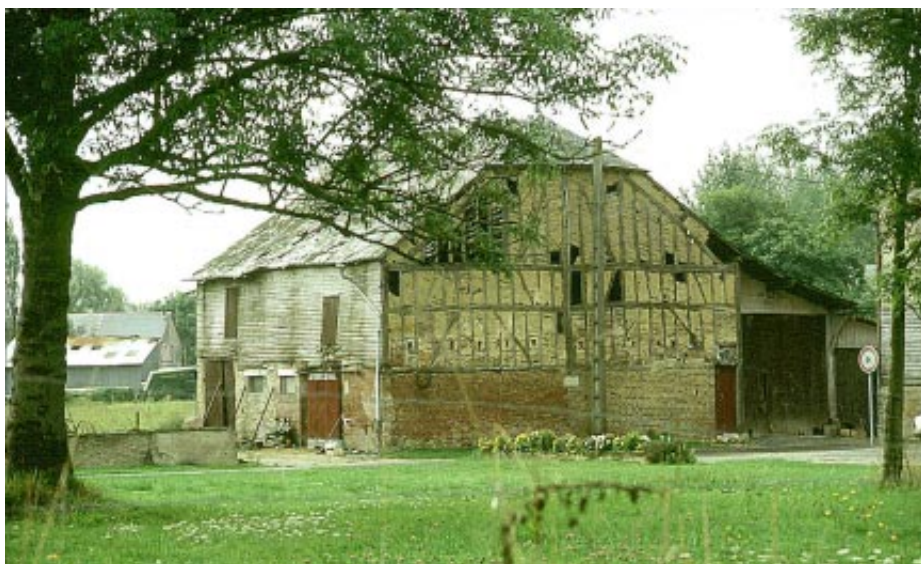
Une belle grange à pans de bois et torchis en ruine, à Corny-Machéroménil
