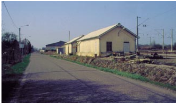
Linéaire d'activités industrielles autour de la voie SNCF dans la Sormonne, à Tournes
