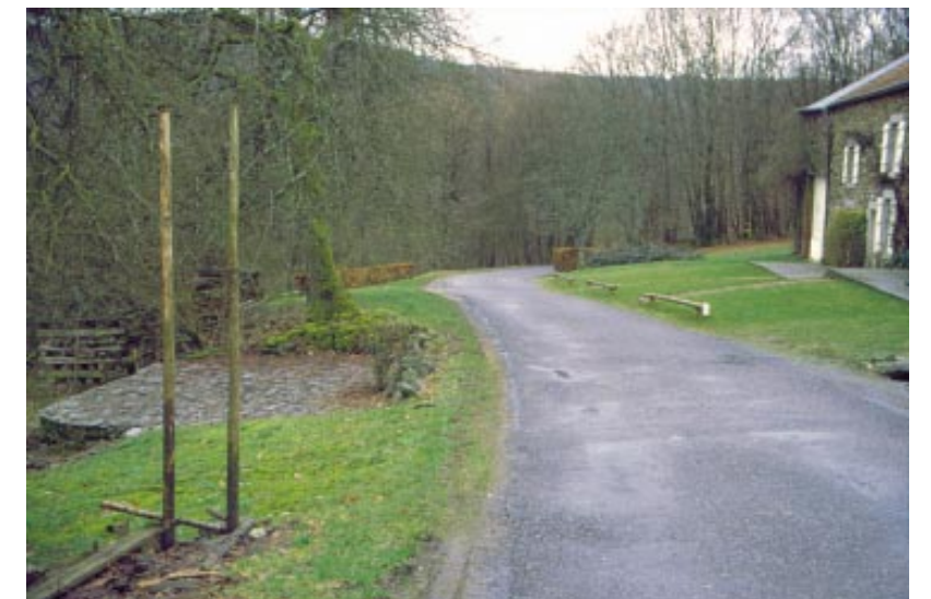
Entre Linchamps et La Neuville-aux-Haies : exemple intéressant d'enherbement des bas-côtés de la route, qui éclaire et égaie le parcours tout en réduisant visuellement l'emprise routière.
