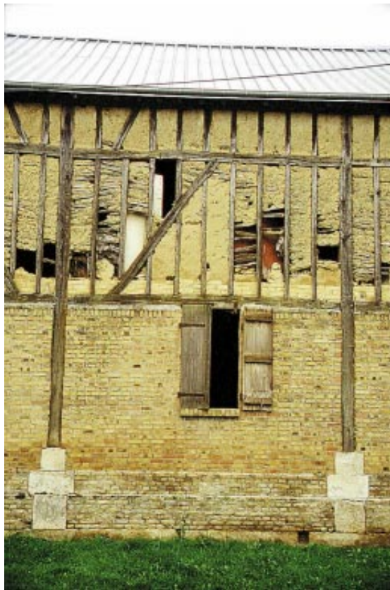
Association brique, pan de bois et torchis à Puisseux. Un patrimoine fragile
