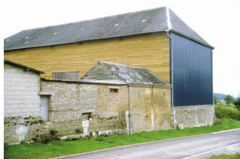
réhabilitation d'un bâtiment agricole en bois et tôle bleu sombre, à Puisseux
