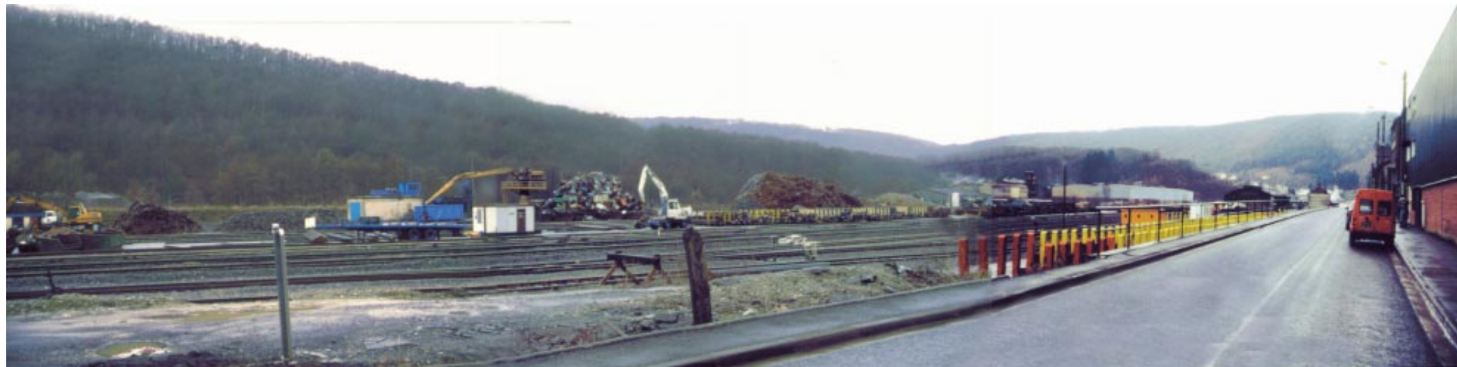
Etat existant / Nouzonville : activités autour de la voie SNCF, visible depuis la RD 988 (à droite)
