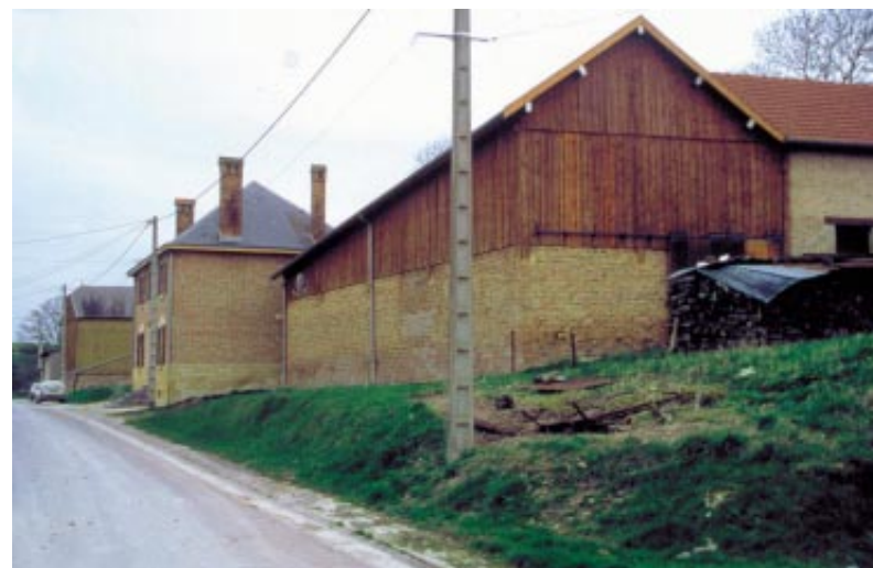
réhabilitation de bâtiment agricole en brique et bois, à Liry
