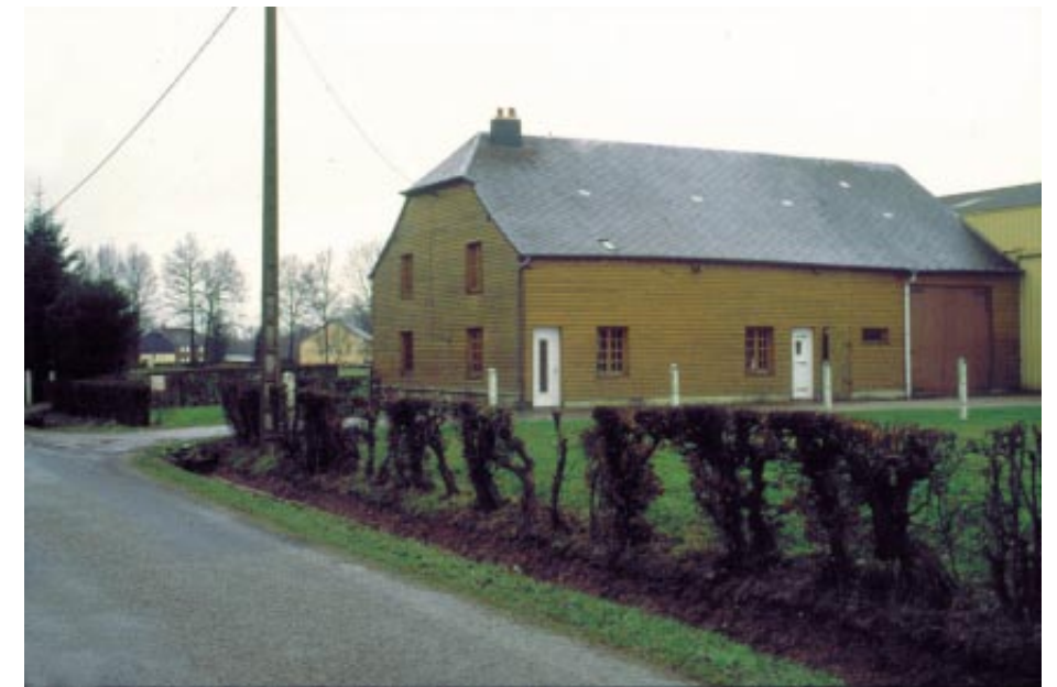
Maison à pans de bois réhabilitée, vers les Taillettes
