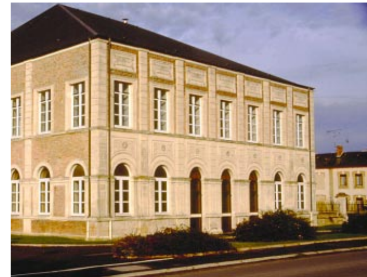
reconversion d'un bâtiment d'activité en école, au Châtelet-sur-Retourne
