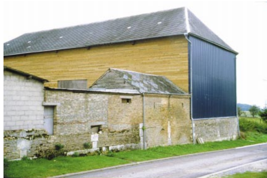
Bâtiment agricole moderne à Puisseux, utilisant le bois
