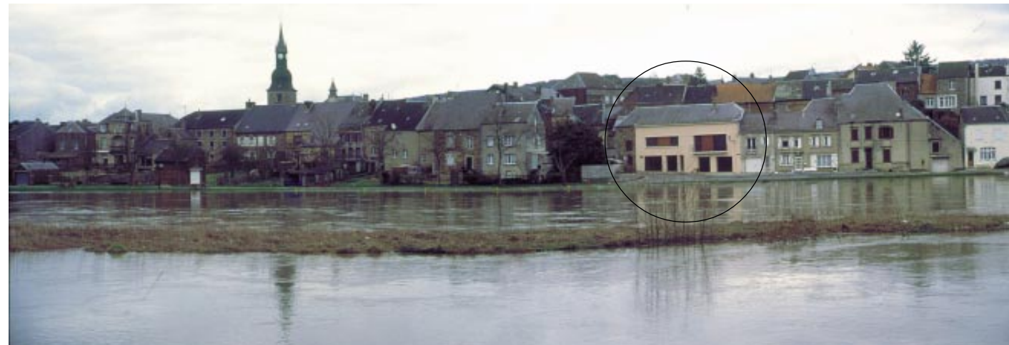
Façade fluviale de Vireux-Wallerand : elle montre l'importance toute particulière de la maîtrise architecturale du bâti sur ces façades offertes au regard. Le rond souligne un point noir architectural.
