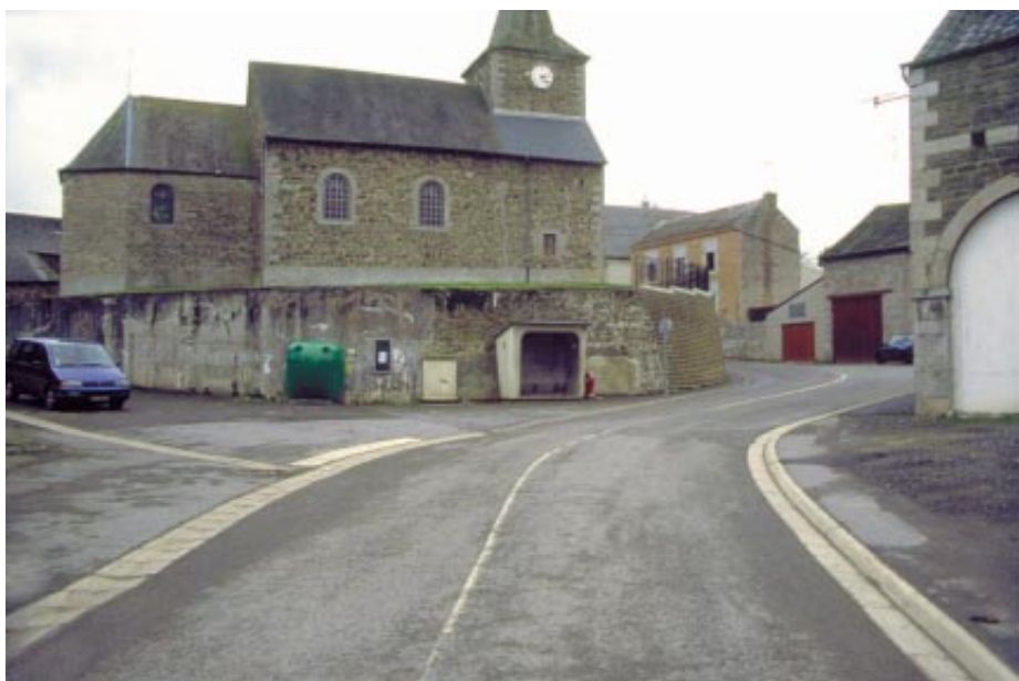
Ham. Exemple d'espace public à revaloriser. l'église est coupée de la "place" par le mur infranchissable ; les équipements font tapisserie : conteneur poubelle, coffret électrique, abri-bus, ...
