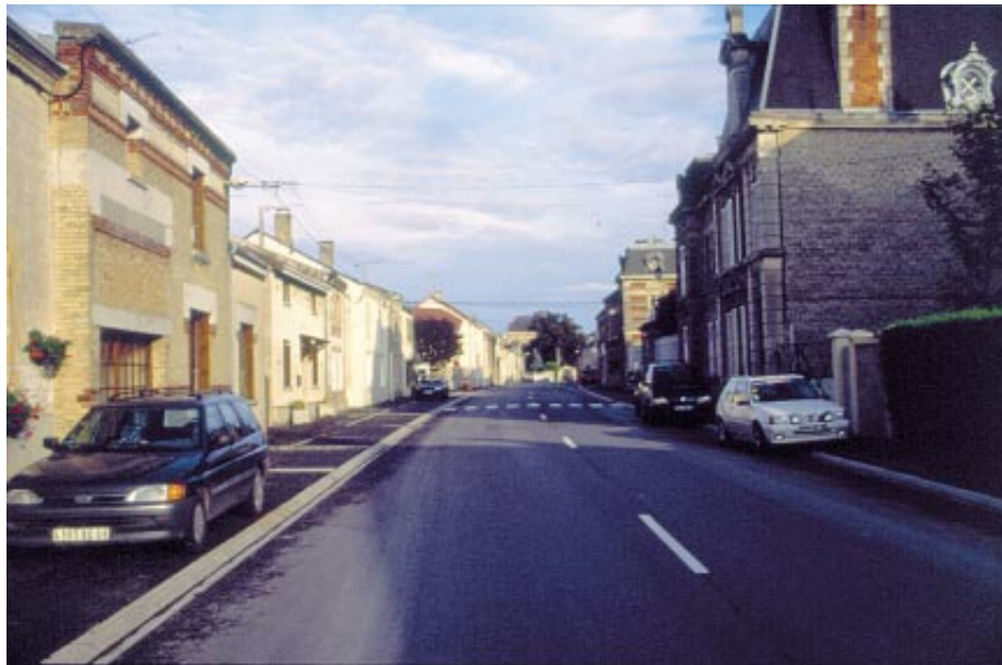
Neuflize : exemple de traversée à requalifier
