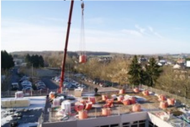
Évacuation des matériaux
