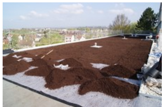
Mise en place du substrat
