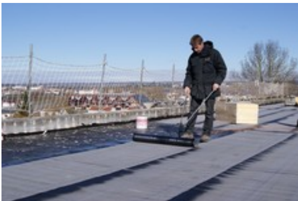
Pose de l'étanchéité
