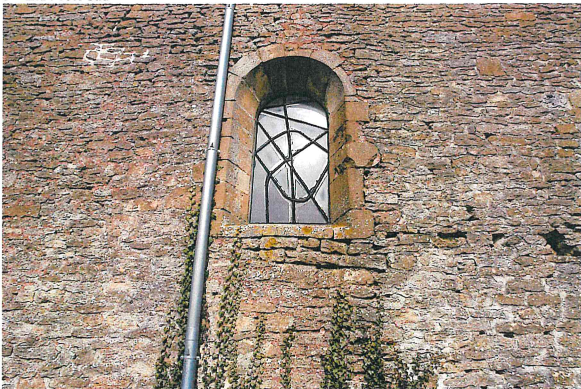
4 – nef, mur sud, baie n° 6
