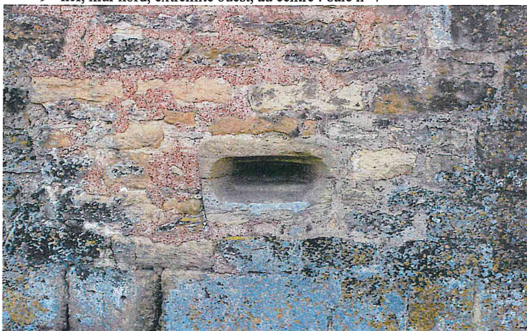
10 - nef, mur nord, extrémité ouest : ouverture de tir
