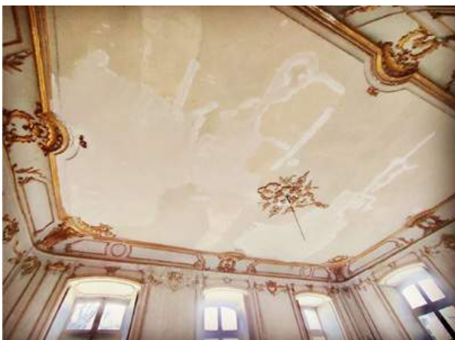
Restauration des plafonds du salon doré de l'Abbaye de Chatel-Chéhéry
