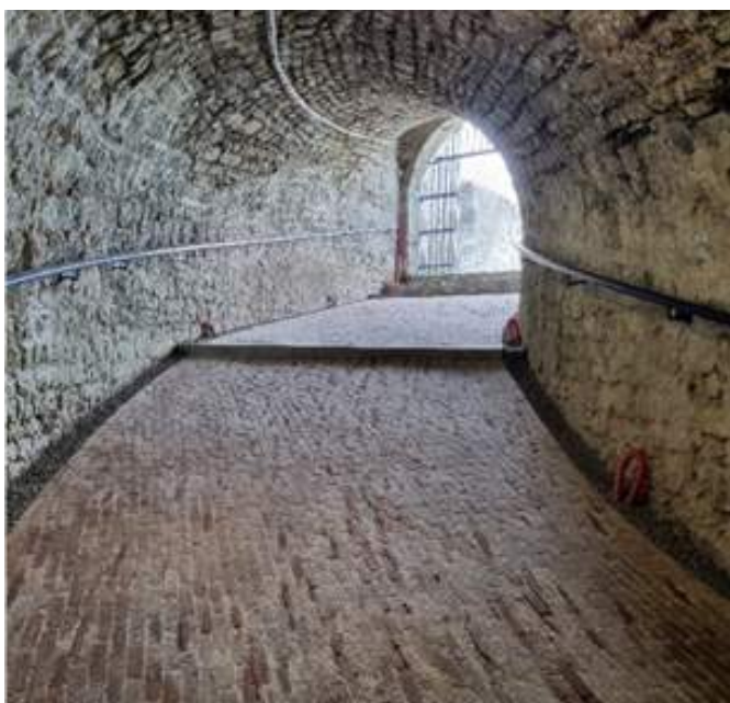
Restauration de la rampe à canons au fort de Charlemont, Givet
