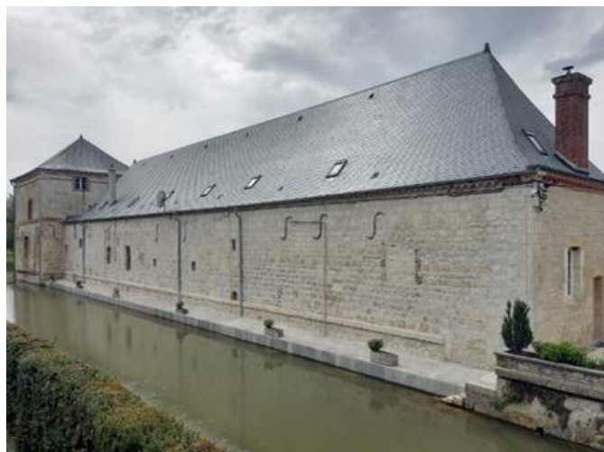
Restauration des couvertures et façades des communs du château de Mesmont
