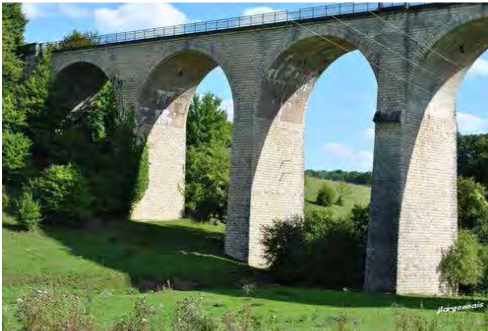
Viaduc d'Ariétal - AUDRR
