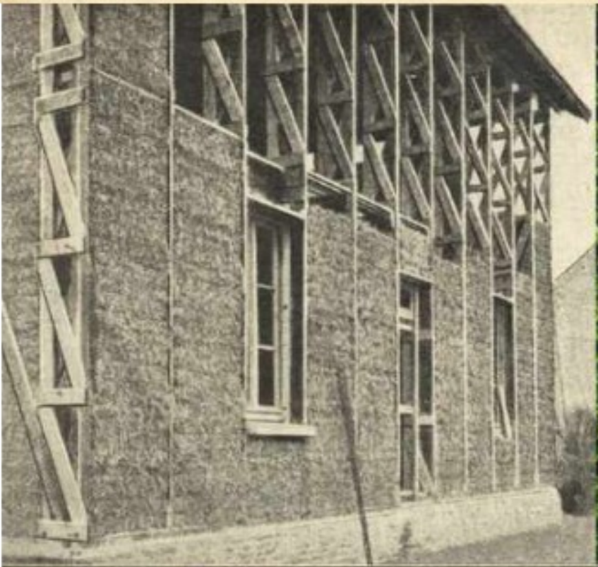
LES MURS DE LA MAISON ISOTE Les blocs de paille comprimée sont superposés.
