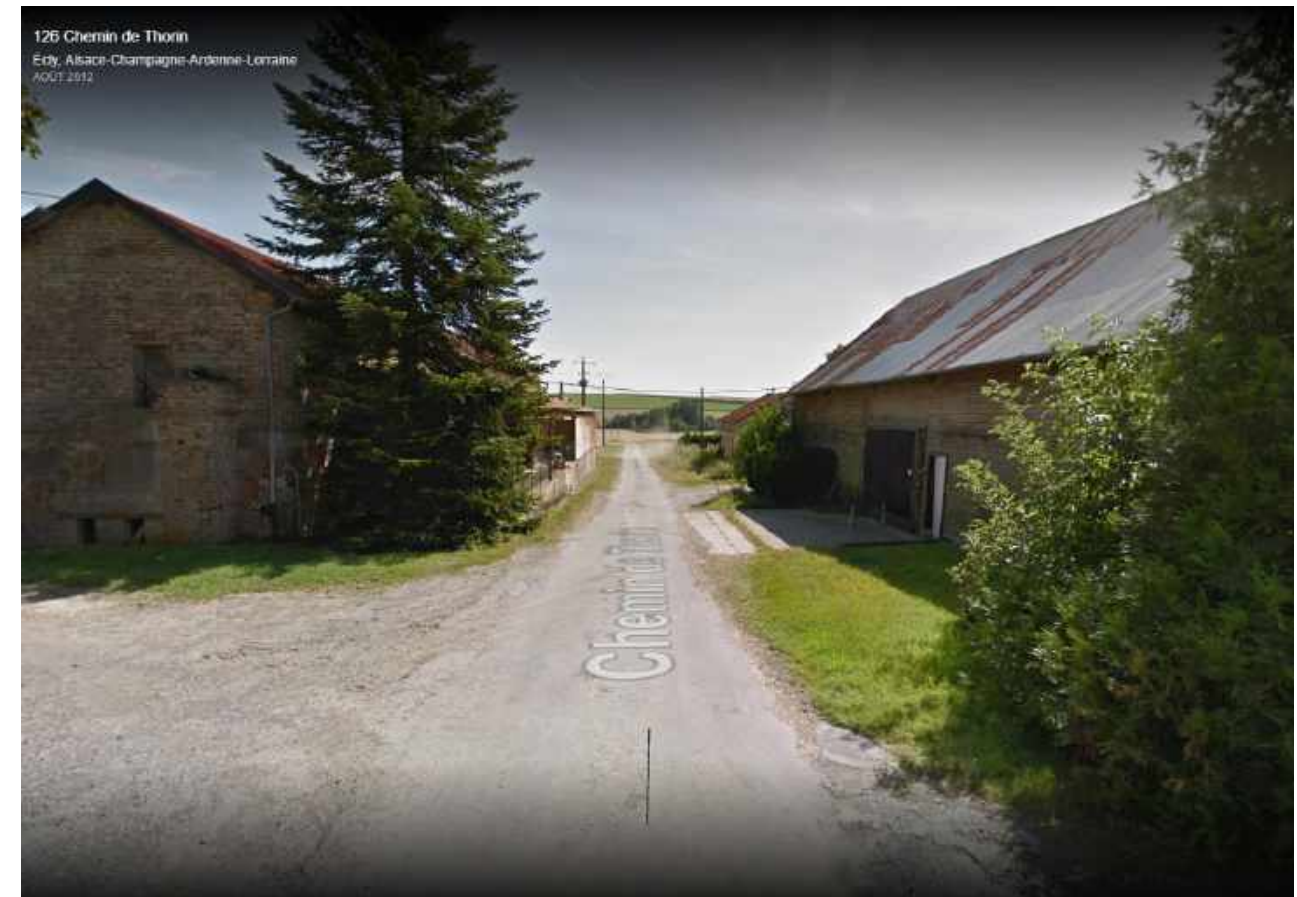
Figure 2 : Vue sur les bâtiments des vergers de Thorin Source : googlemaps
