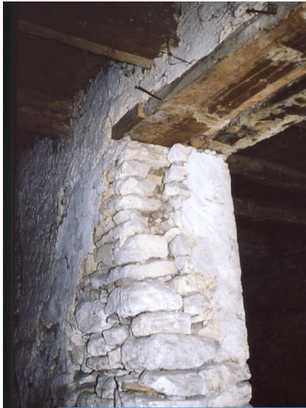
Maçonnerie porteuse
