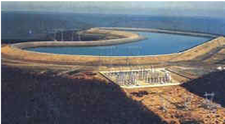
Bassin des Marquisades (bassin supérieur)
