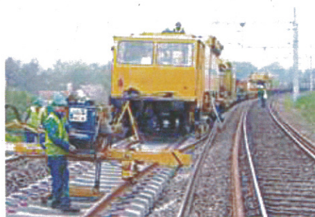
Longs rails soudés sur traverses béton
