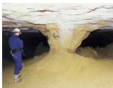
↗ Vue d'un pilier ruiné dans une ancienne carrière souterraine.
