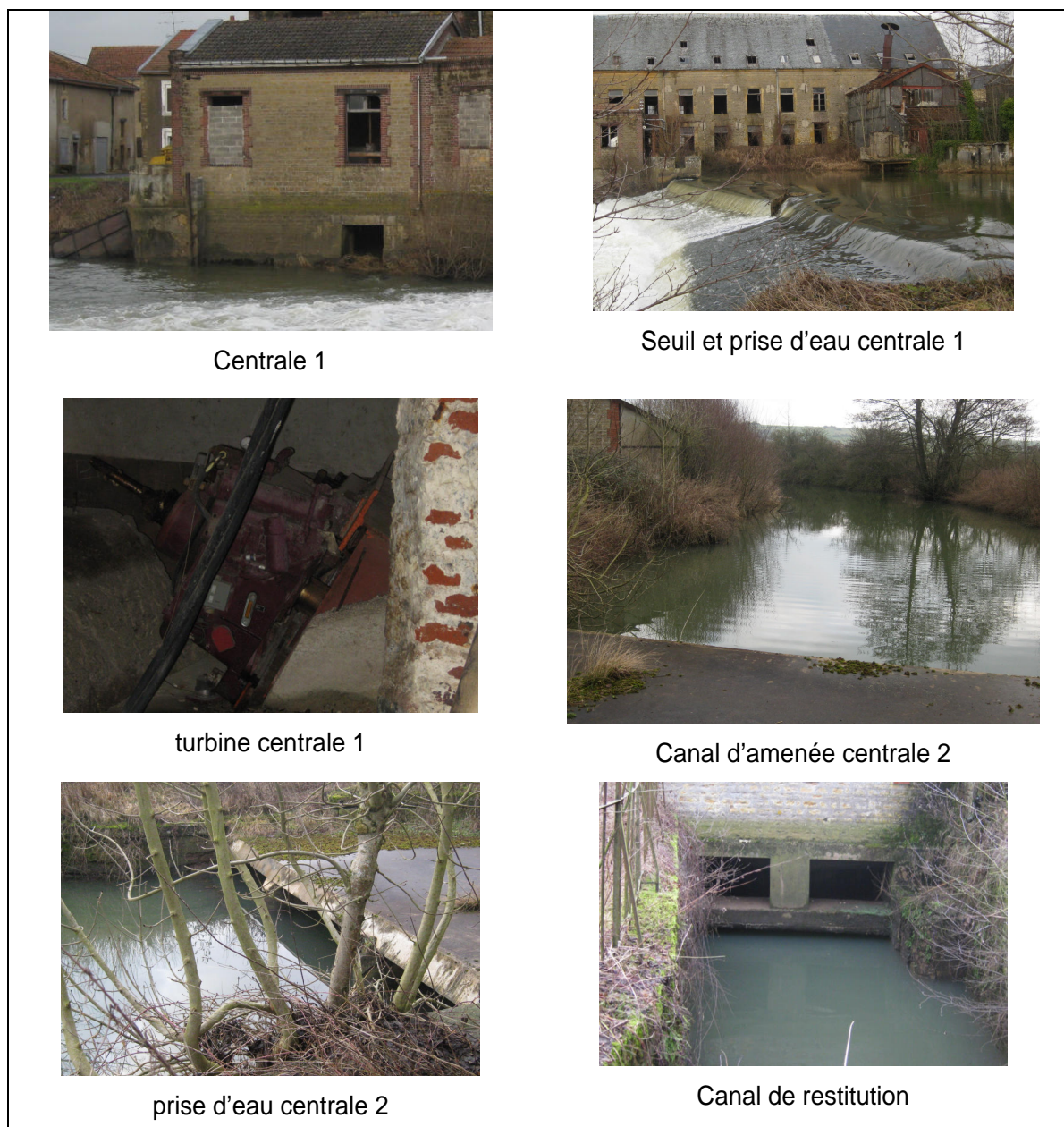
Figure 6 : photos de l'ouvrage de la Ferté sur Chiens
