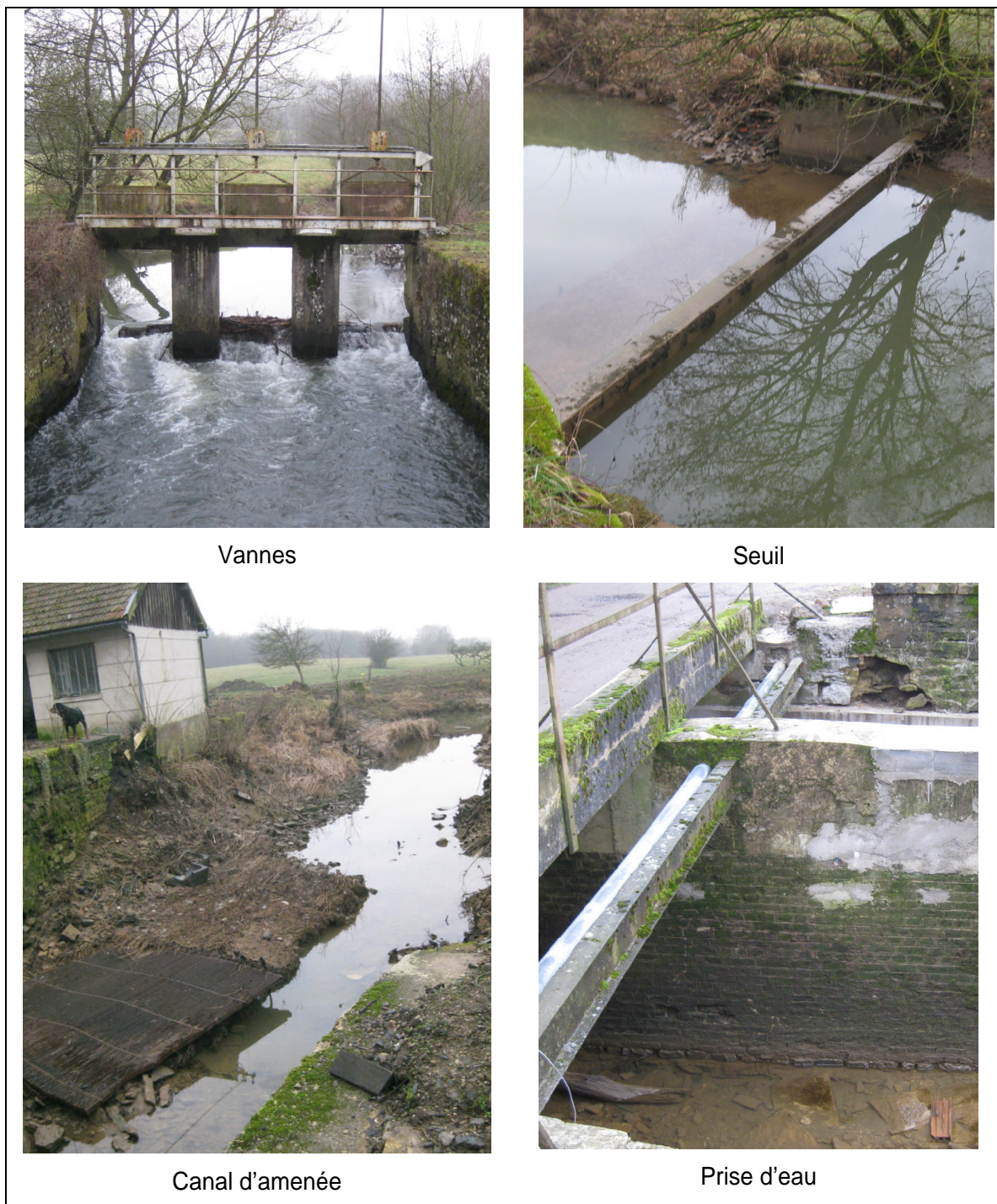
Figure 3 : photos de l'ouvrage du Moulin de la Grange aux Bois
